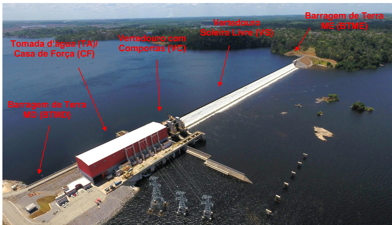
Figura 1. Barragem Cachoeira Caldeirão. Fonte: Cachoeira Energia S.A. (Imagens aéreas: DJI_0004)
